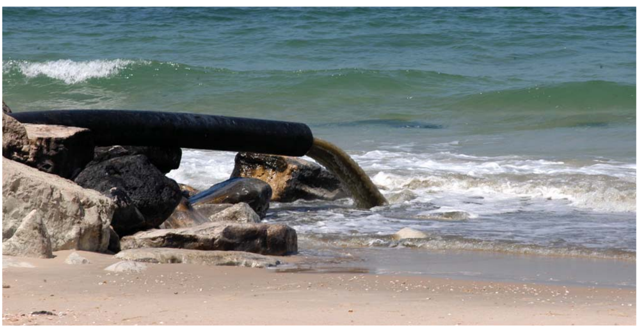
منفذ تصريف مياه الصرف الصحي، شاطئ رفح، نيسان/أبريل 2009.
